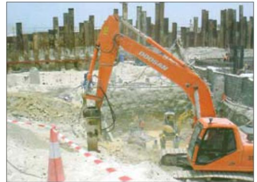
أعمال الحفر بالقرب من البرج C
