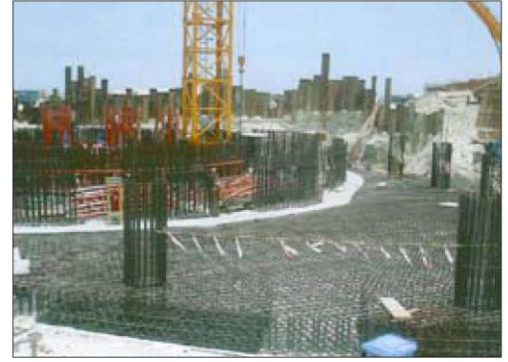
تركيب الألواح الأسمنتية في الطابق الأرضي من البرج C
